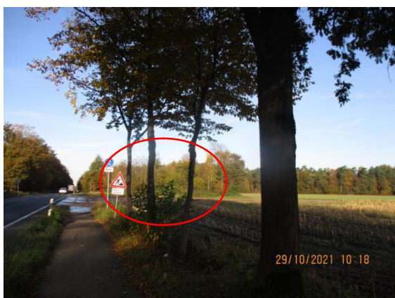
Foto 10: Erschließung der WEA-1-Kreulkerhok – Fällung von drei Bäumen – Blick nach Westen
