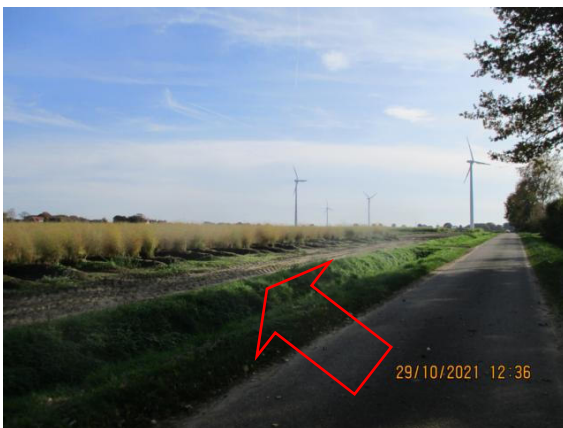
Foto 1: Erschließung der WEA-HS1 – Ackerfläche und Gewässer Nr. 1460 – Blick nach Süden
