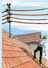
Bild 4: Dacharbeiten in der Nähe von Niederspannungsfreileitungen
