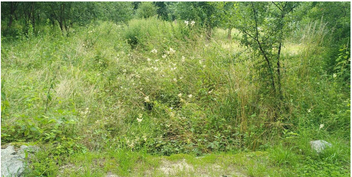
Abbildung 9 Sundergraben westlich des Weges, Blick flussabwärts ab Durchlass in Wegeverbindung
