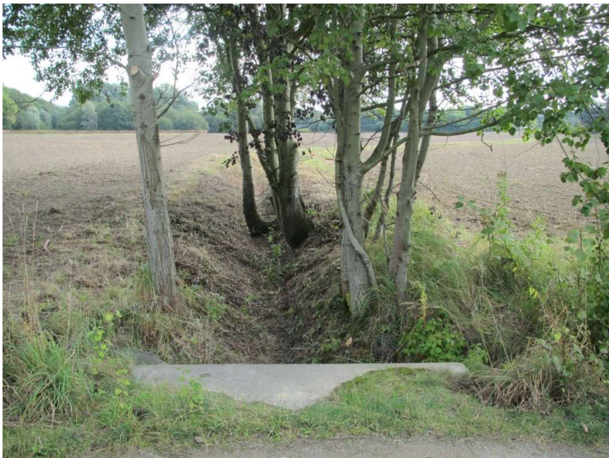
Abbildung 2 Blick gegen die Fließrichtung des Sundergrabens (Standpunkt auf vorhandenem Durchlass)
