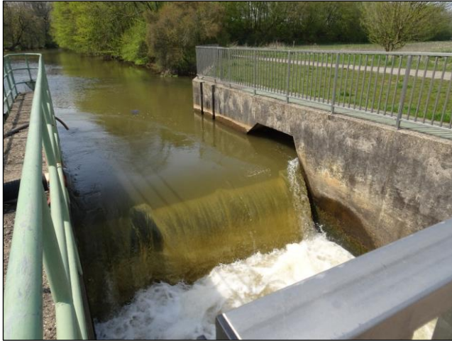
Abbildung 24: Zweifeldrige Wehranlage W8 Kottmann, offene Wehrklappe (links) und geschlossene Wehrklappe (rechts), Blick flussaufwärts, Fotos vom 07.05.21
