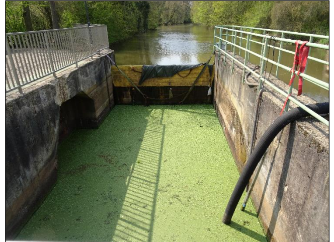
Abbildung 24: Zweifeldrige Wehranlage W8 Kottmann, offene Wehrklappe (links) und geschlossene Wehrklappe (rechts), Blick flussaufwärts, Fotos vom 07.05.21
