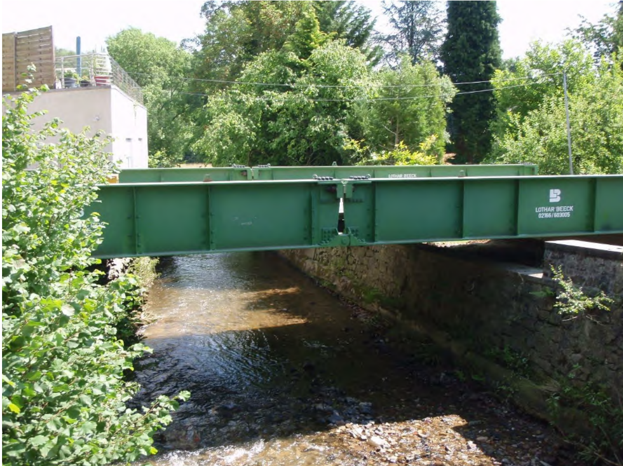
Abb. 6: Beispiel für eine Behelfsbrücke
