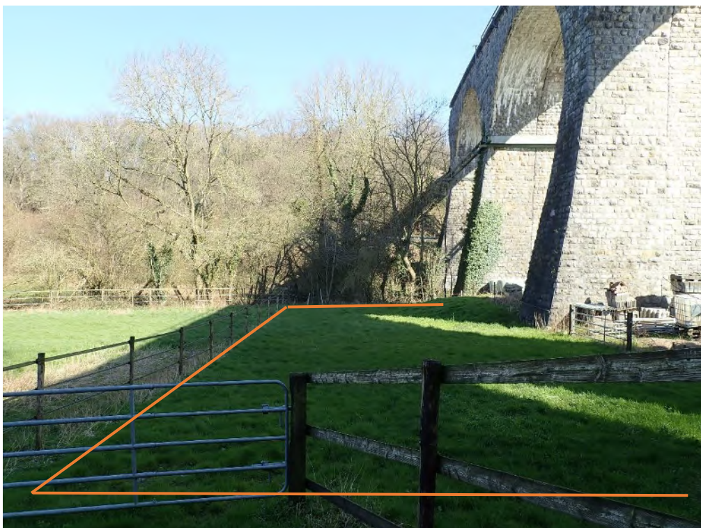
Abb. 19: Baustelleneinrichtungsfläche westlich des Viaduktes
