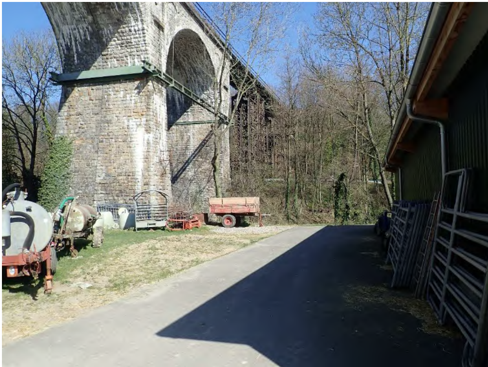
Abb. 18: Baustelleneinrichtungsfläche östlich des Viaduktes
