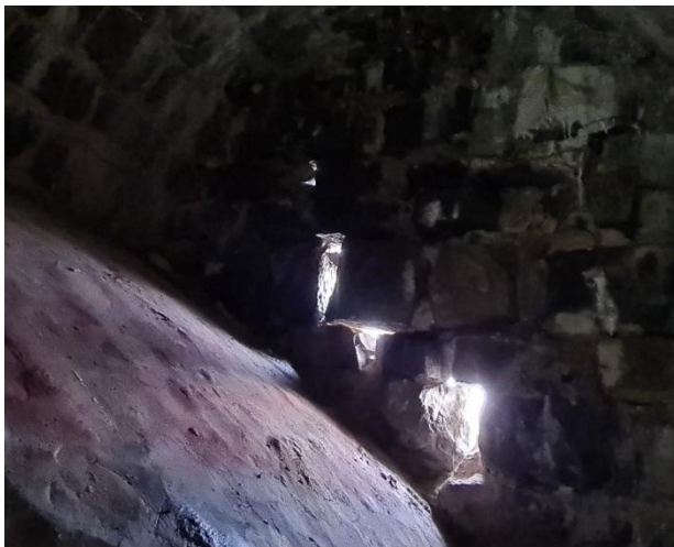
Abbildung 6: Spaltöffnungen in der Brückenkammer
