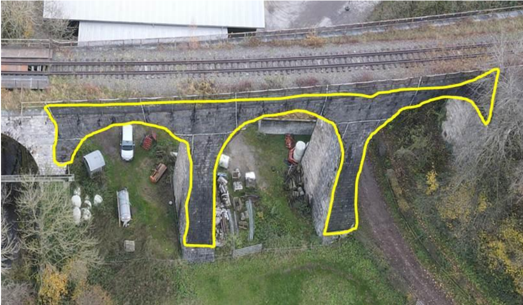
Abbildung 11: Schutznetze Ansicht von Westen. Gelb markiert ist der etwaige Verlauf der Netze.
