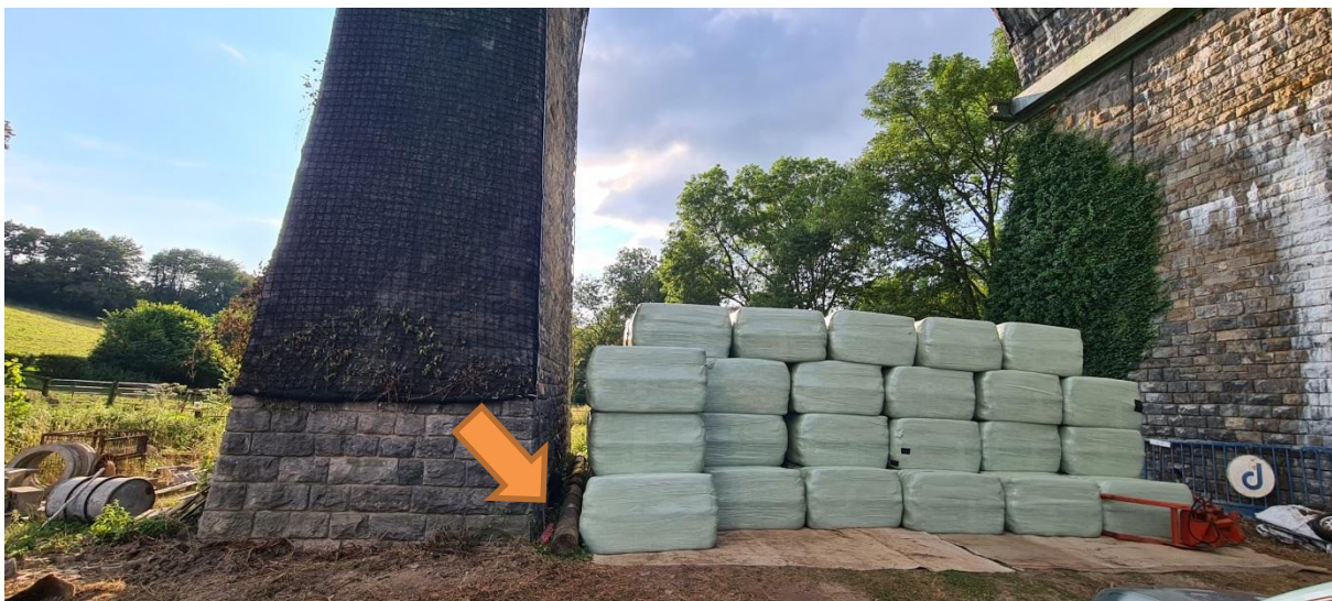
Abbildung 15: Unter der Brücke gelagerte Heuballen. Der Pfeil markiert eine der Revisionsklappen.
