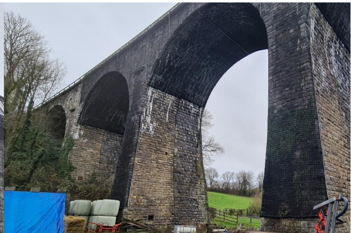
Abbildung 10: Schutznetz Ansicht von Osten und unter die Bögen.
