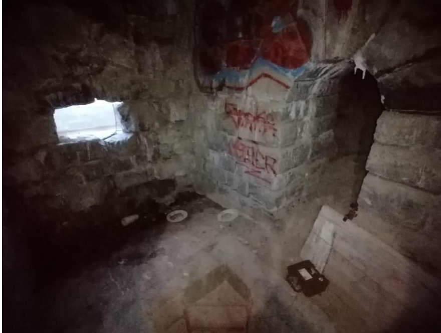
Abbildung 16: Horchkiste in der Brückenkammer im Pfeiler 3 unweit der großen Öffnung.
