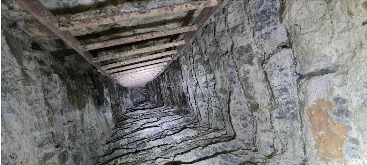
Abbildung 5: Klettergang im Brückenpfeiler.
