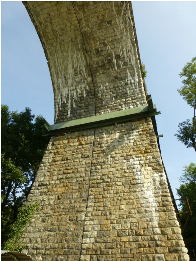
Abb. 1: Falkenbachviadukt Ansicht Pfeiler und Bogen
