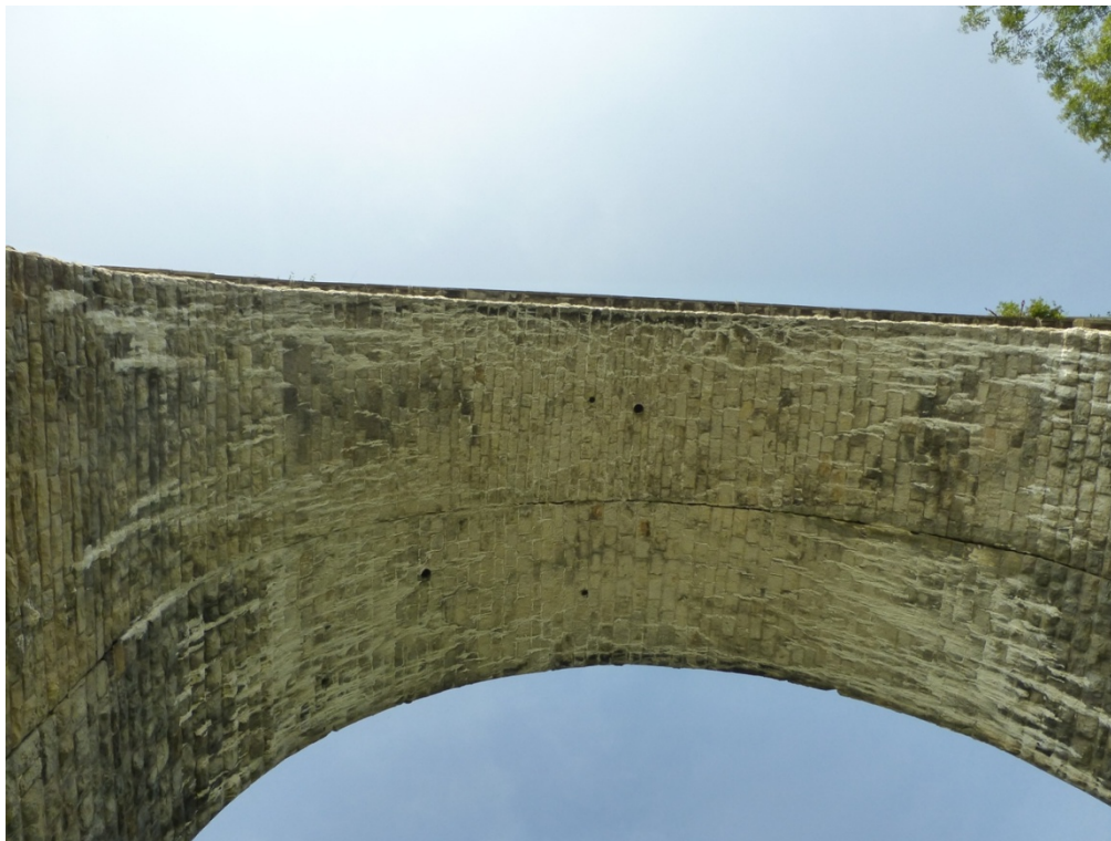
Abb. 2: Falkenbachviadukt Ansicht Bogen von unten
