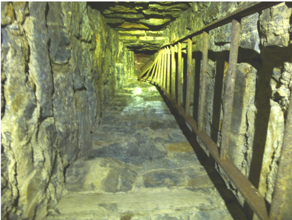
Abb. 4: Klettergang mit Leiter in Brückenpfeiler
