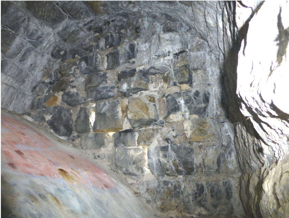
Abb. 5: Kammer über Bogen in Brückenpfeiler
