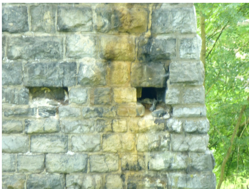
Abb. 6: Öffnung im nördlichen Brückenteil
