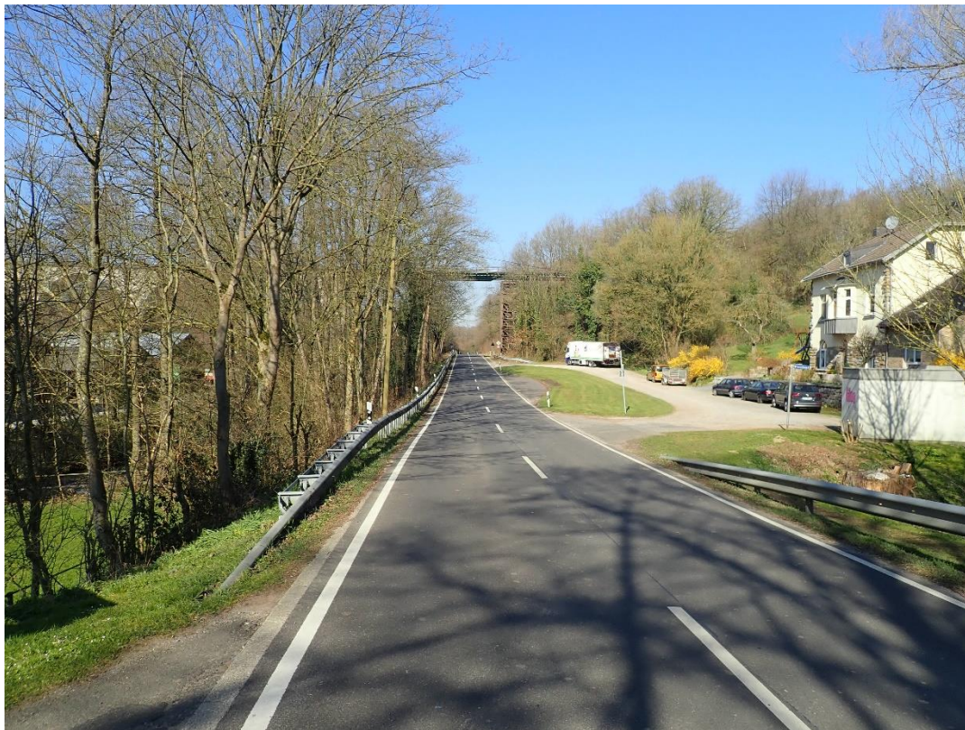
Abb. 10: Blick auf das Falkenbachviadukt (FR Kornelimünster) mit Venwegener Straße und Parkplatz
