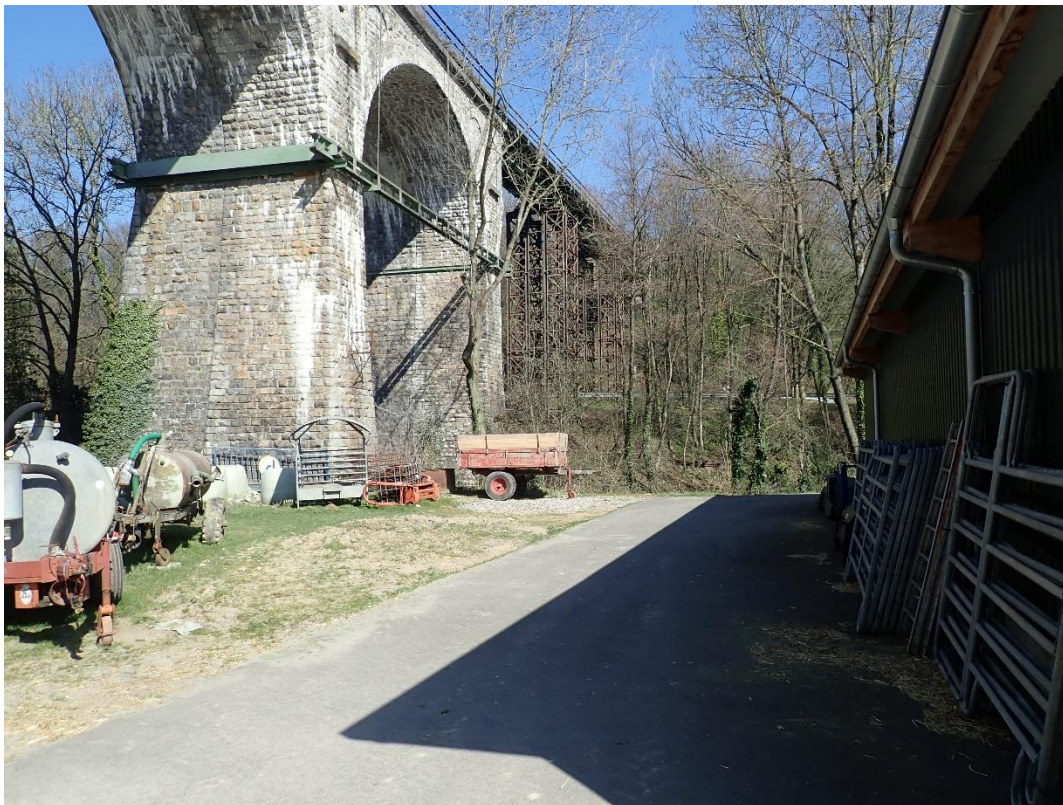
Abb. 12: Falkenbachviadukt (Richtung S - N) mit angrenzendem Reiterhof
