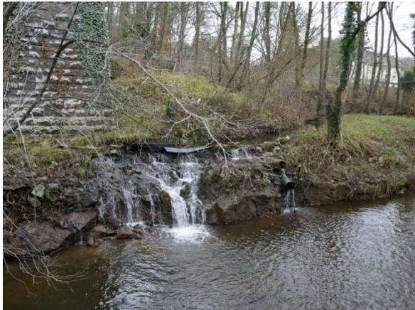
Abb. 42: defekte Endfassung des Mühlengrabens<sup>100</sup>
