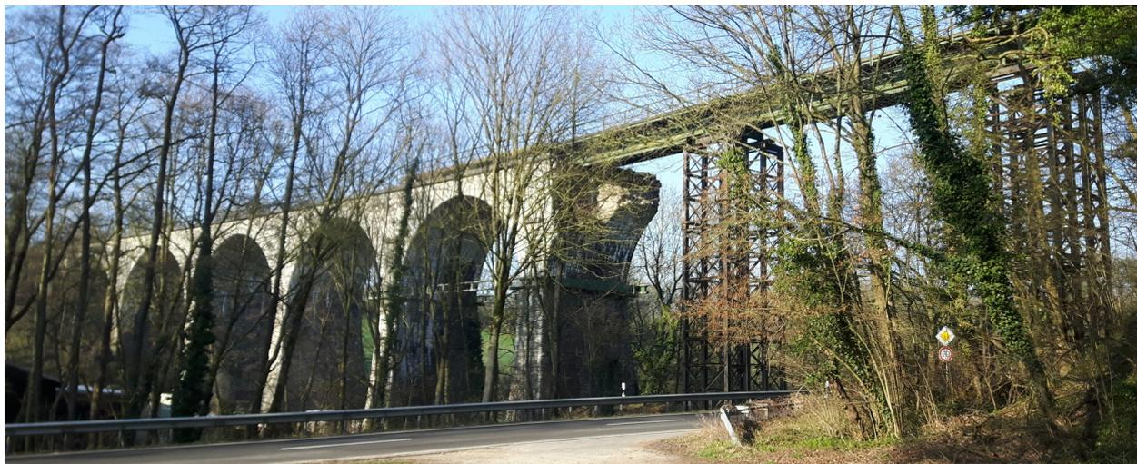
Abbildung 5: Gesamtansicht Ostseite mit Behelfskonstruktion
