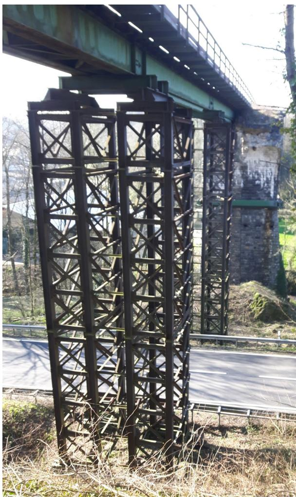
Abbildung 6: Behelfskonstruktion
