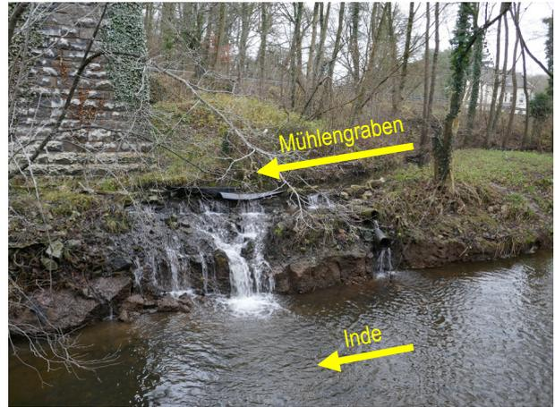
Abbildung 9: defekte Einfassung d. Mühlengrabens
