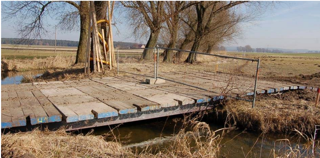
Abbildung 3: Beispiel einer Gewässerüberfahrt mittels Pionierbrücke
