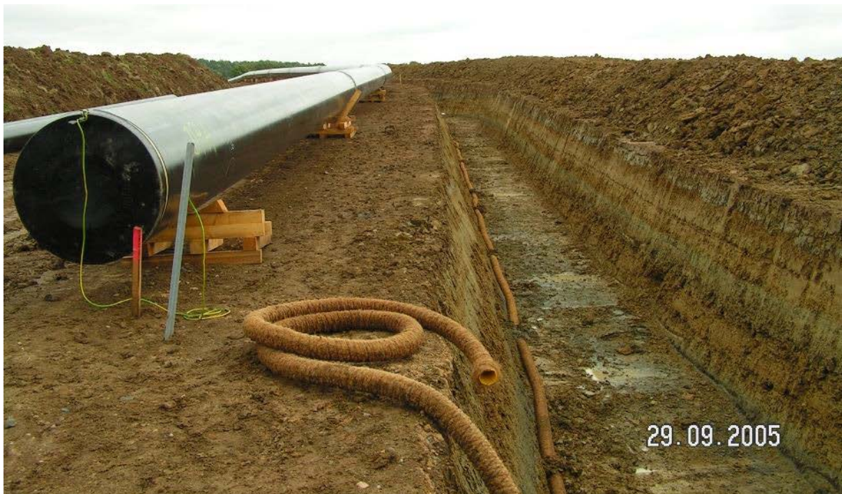
Abbildung 6: Beispiel offener Rohrgraben
