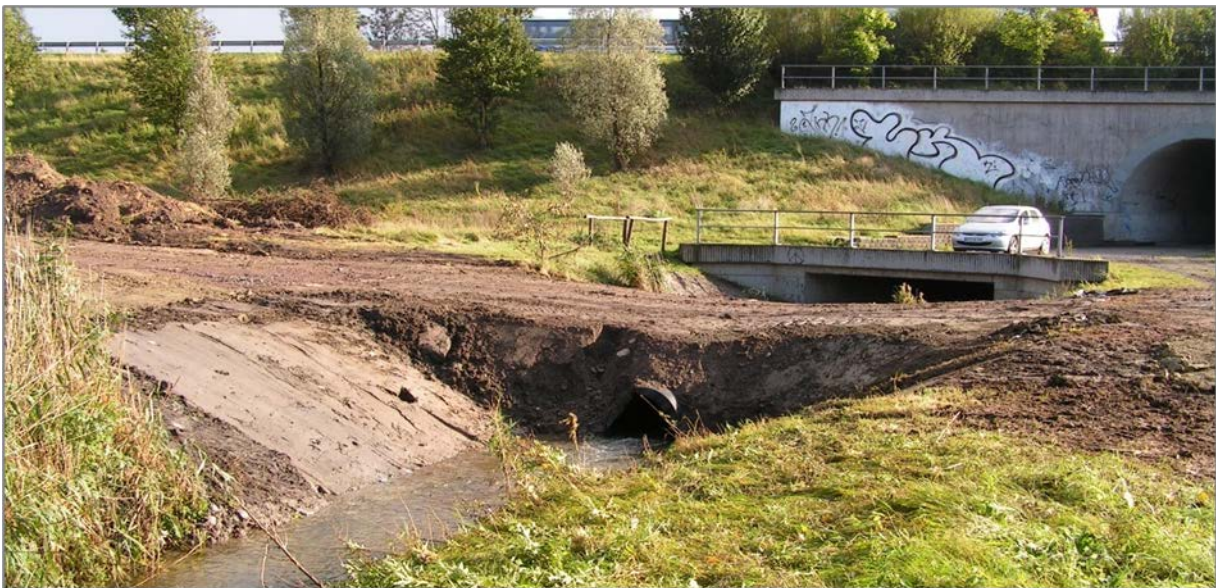
Abbildung 2: Beispiel einer Gewässerüberfahrt mit temporärem Rohrdurchlass
