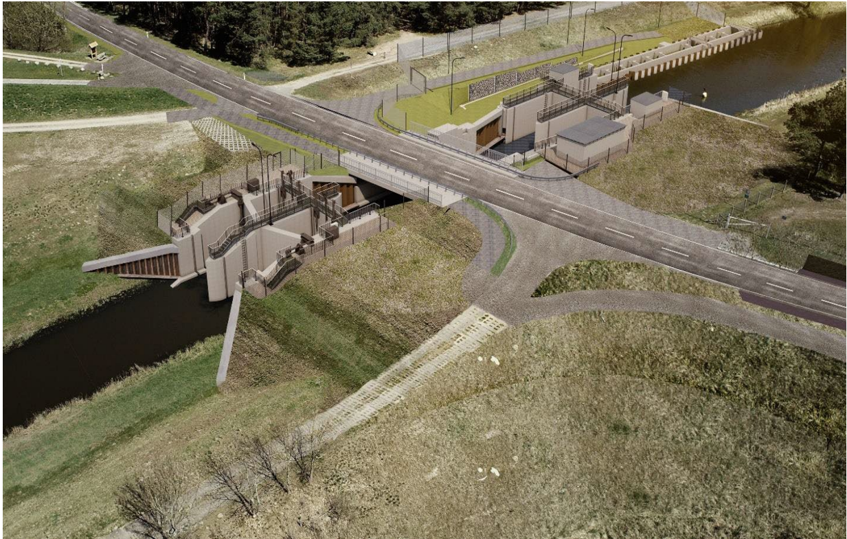
Bildrechte: Planungsgemeinschaft KREBS+KIEFER/IRS Stahlwasserbau im Auftrag des NLWKN/NLStBV
