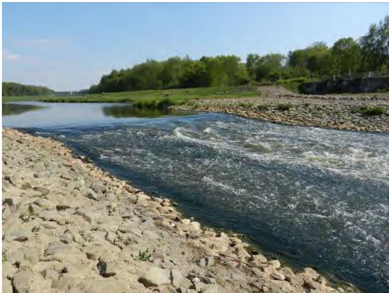
Abbildung 24: Raugerinne ohne Einbauten (Quelle: DWA-M 509)
