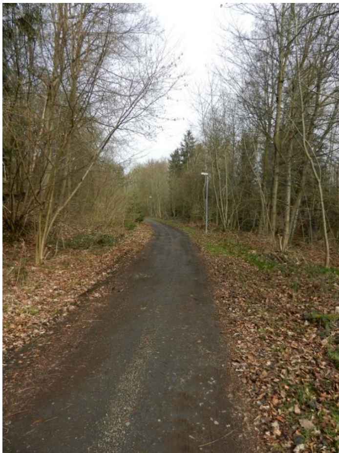
Abbildung 5-7: Zu asphaltierende Verkehrsfläche (Quelle: ETC 2021)
