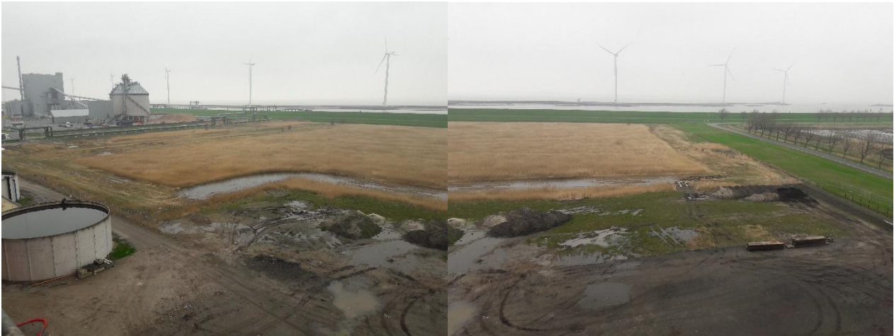
Abbildung 1 Der geplante Standort für Linie vier an der Nordseite der heutigen Anlage. Das Foto wurde vom Dach des Gebäudes aus genommen. (Quelle: eigenes Foto).
