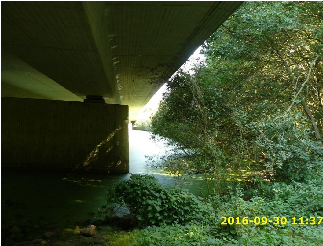
Abbildung A 8: SG 1.4 – Gewässer unter dem Hochwasserdurchlass an der E 233
