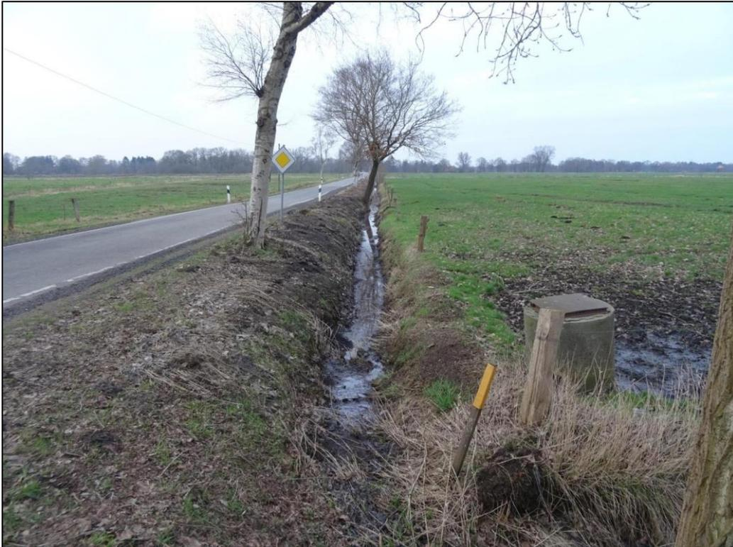
Abbildung 3: Zu verrohrender Graben bei Maßnahme Nr. 1. Der geringe Wasserstand im Winter wird deutlich. Im Sommer war der Graben ausgetrocknet.
