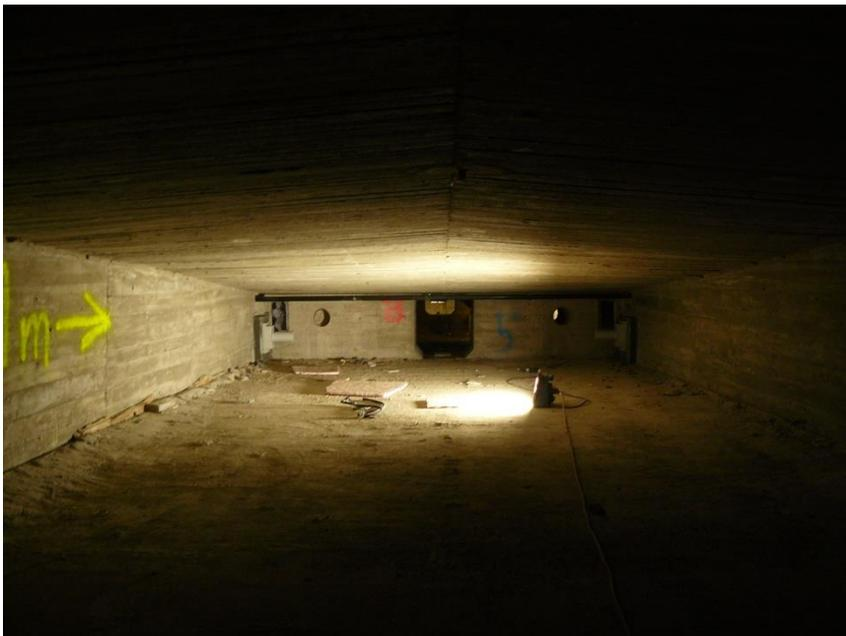
**Abbildung A 8:** Über die gesamte Länge der Brücke an der Hildesheimer Straße verlaufender Hohlraum.
