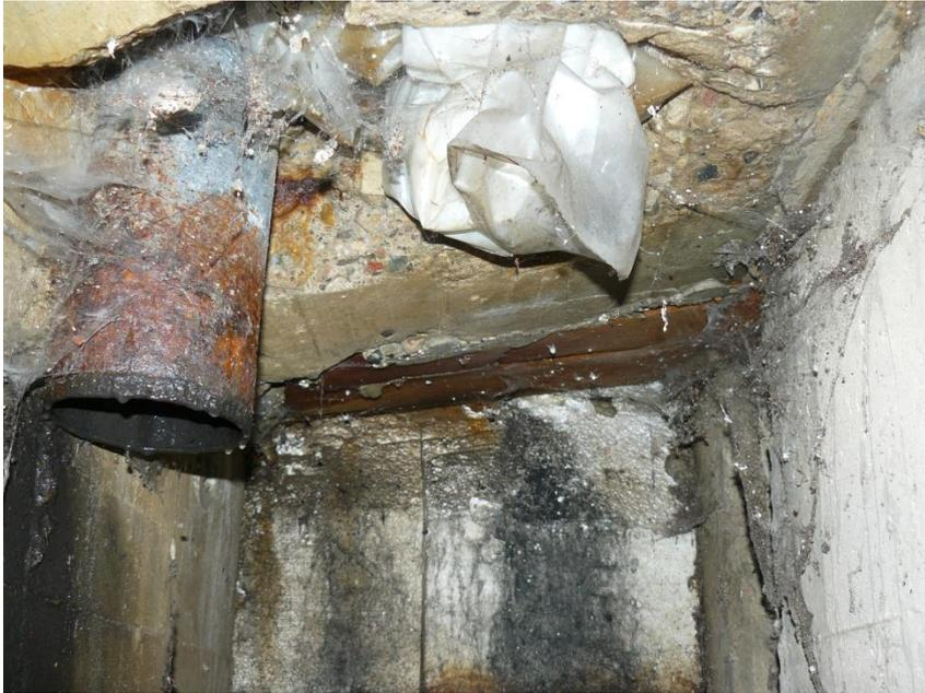
**Abbildung A 7:** Hohlraum im Bereich der Widerlager der Leinebrücke.
