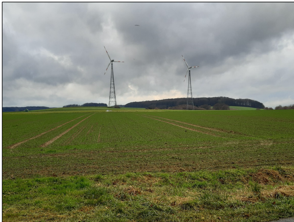
Abb. 2: Blick auf die WEA-Altanlagen von Osten
