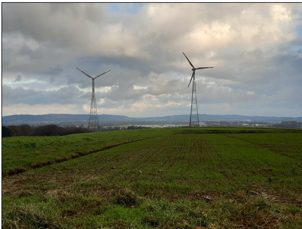
Abb. 1: Blick auf die WEA-Altanlagen von Westen
