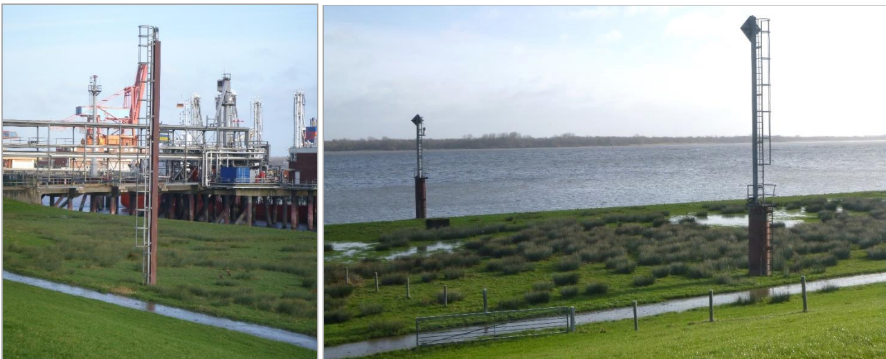
Abbildung 8: Richtfeuer und Hafeneinfahrtsfeuer im Deichvorland des Südhafens Stade-Bützfleth links: bestehendes Richtfeuer südlich der Zufahrt zum Löschkopf III (Quelle: NPorts) rechts: bestehende Hafeneinfahrtsfeuer südlich des Löschkopf III (Quelle: (NPorts)
