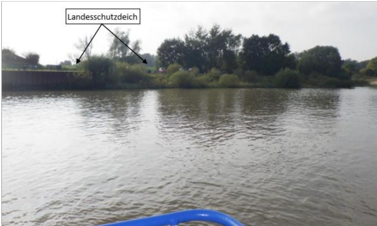
Abbildung 109: Vorhabengebiet (Deicherhöhung) aus Richtung Fähranleger Stadersand
