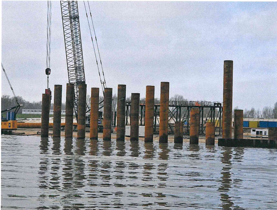
Abbildung 2: Tragrohre der Liegewand (2. Pfahl von rechts: der Pfahl T-122)
