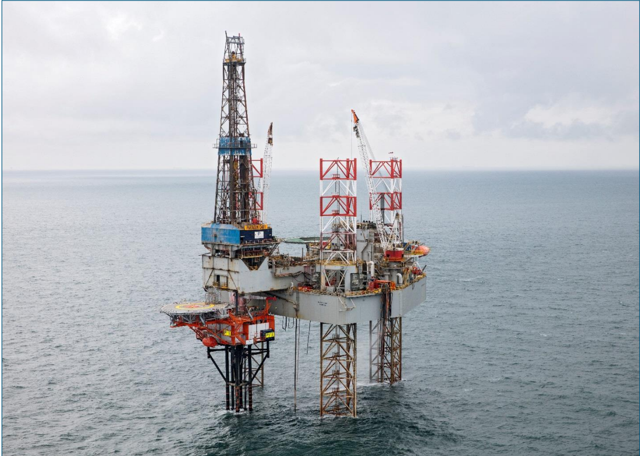
Abbildung 6: Eine Bohrplattform (rechts), die über einer Erdgasförderplattform (links) installiert wurde. (© Foto & Video Honing)
