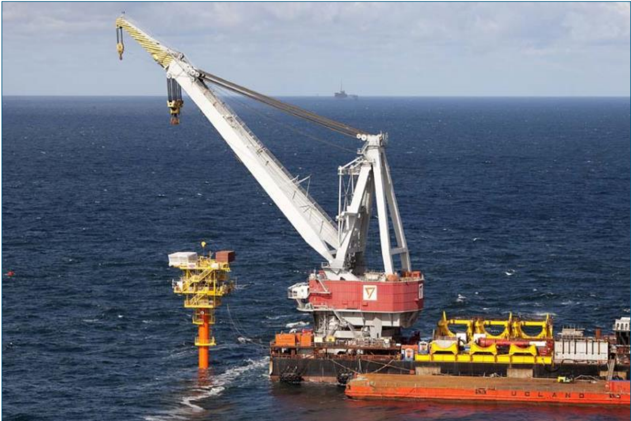
Abbildung 5: Installation einer Satellitenplattform mit Hilfe eines Schwimmkrans. (© Foto & Video Honing)
