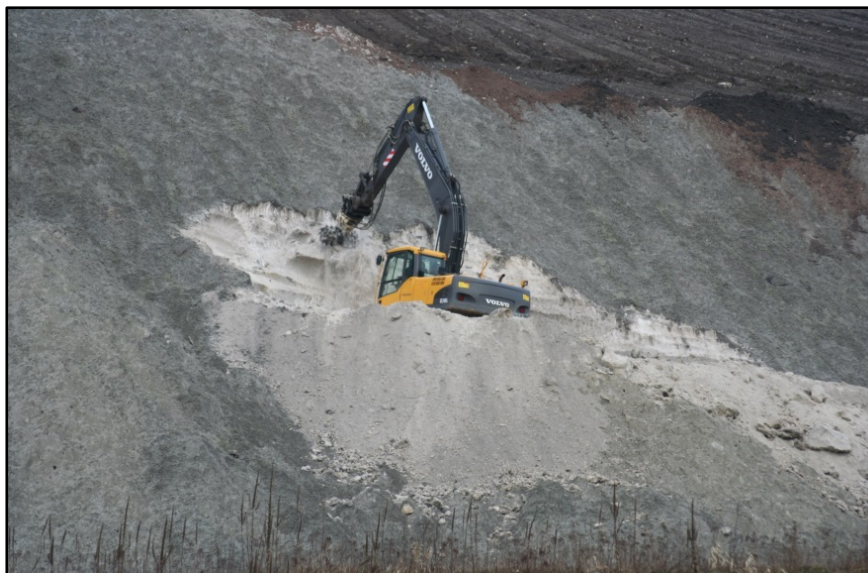
Abb. A-6: Bagger bei der Abfräsarbeiten (K+S 2014, Halde Friedrichshall)
