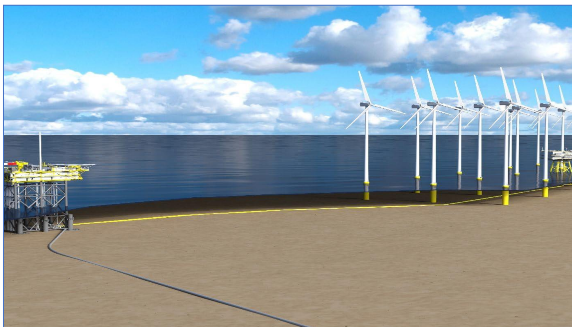
Figuur 1-2 Het N05-A transportplatform, de pijpleiding en de stroomkabel
