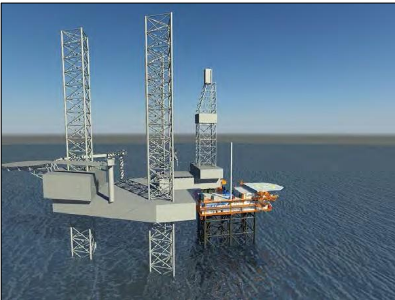
Abbildung 8: Bohrplattform (links) neben der ONE-Dyas-Produktionsplattform (rechts) Quelle: (RHDHV 2020b)
