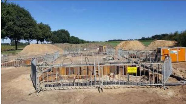
Da der Grundwasserstand stark vom Zeitpunkt der Bauausführung abhängig ist, kann es vorkommen, dass auch an Maststandorten mit hohen Grundwasserständen in niederschlagsschwachen Zeiten keine Grundwasserabsenkung erforderlich ist.
