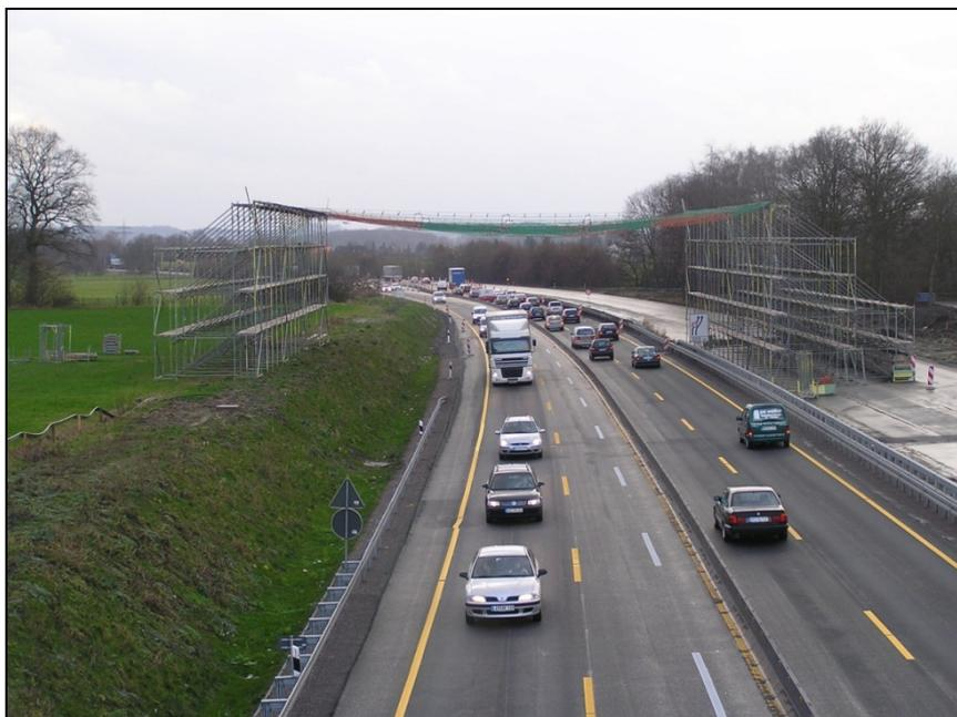
Abbildung 10: Stahlrohrschutzkonstruktion mit Netz über einer Autobahn
