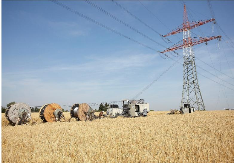
Abbildung 11: Trommelplatz eines 4er-Bündel-Seilzuges
