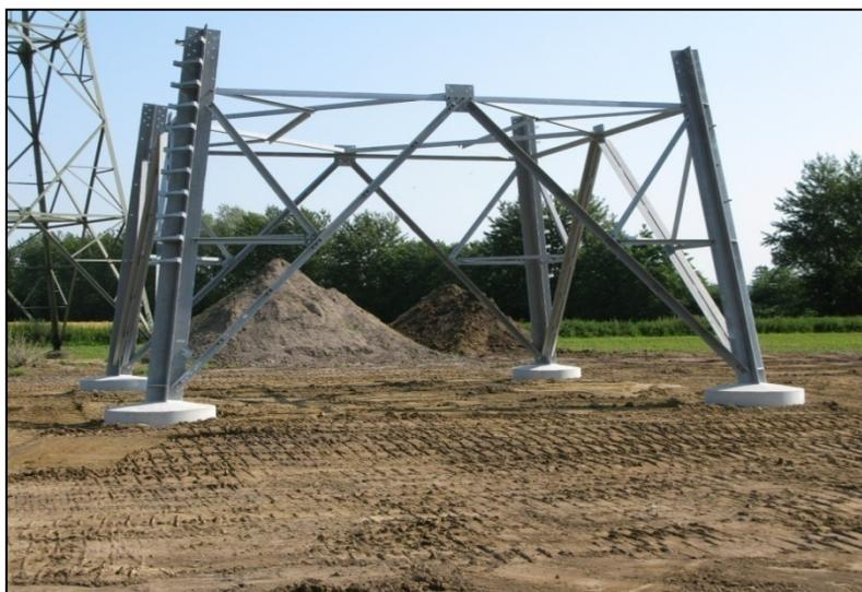
Abbildung 7: Montierter Mastfuß
