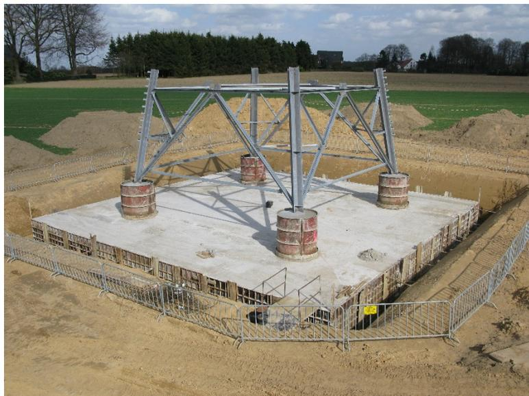
Abbildung 3: Erstellung eines Plattenfundaments
