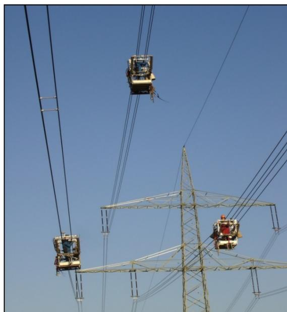
Abbildung 12: Montage der Feldbündelabstandhalter mit Fahrwagen
