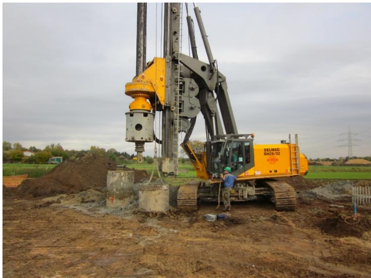
Abbildung 4: Bohrung für einen Bohrpfahl
