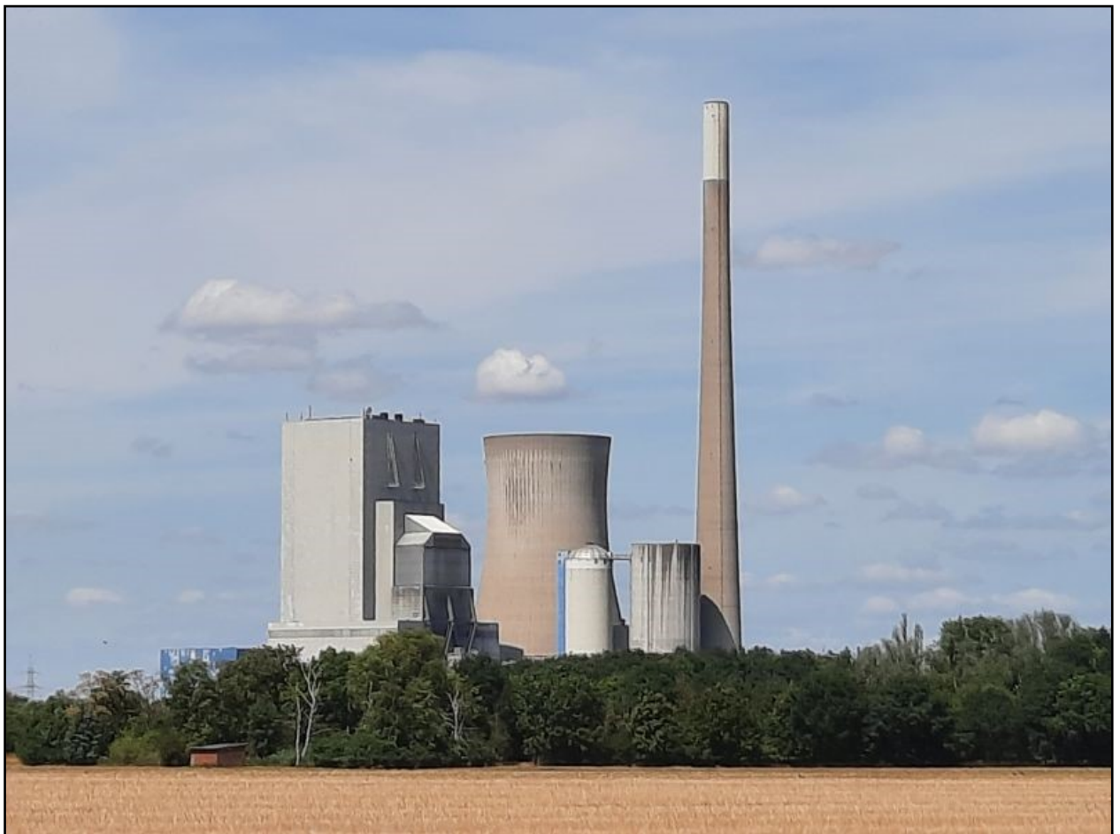
Abbildung 3.2: KW Mehrum (Foto: enco GmbH 2023)
