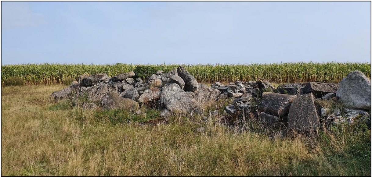
Abb. 21: Betonbrockenhalde auf der östlichen alten Landebahn.
