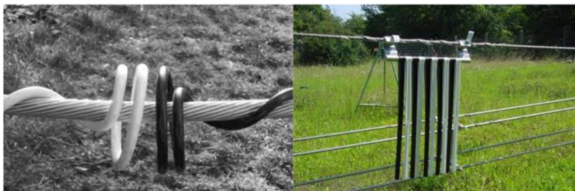
Abbildung 7: Beispiele für Vogelschutzmarker.
