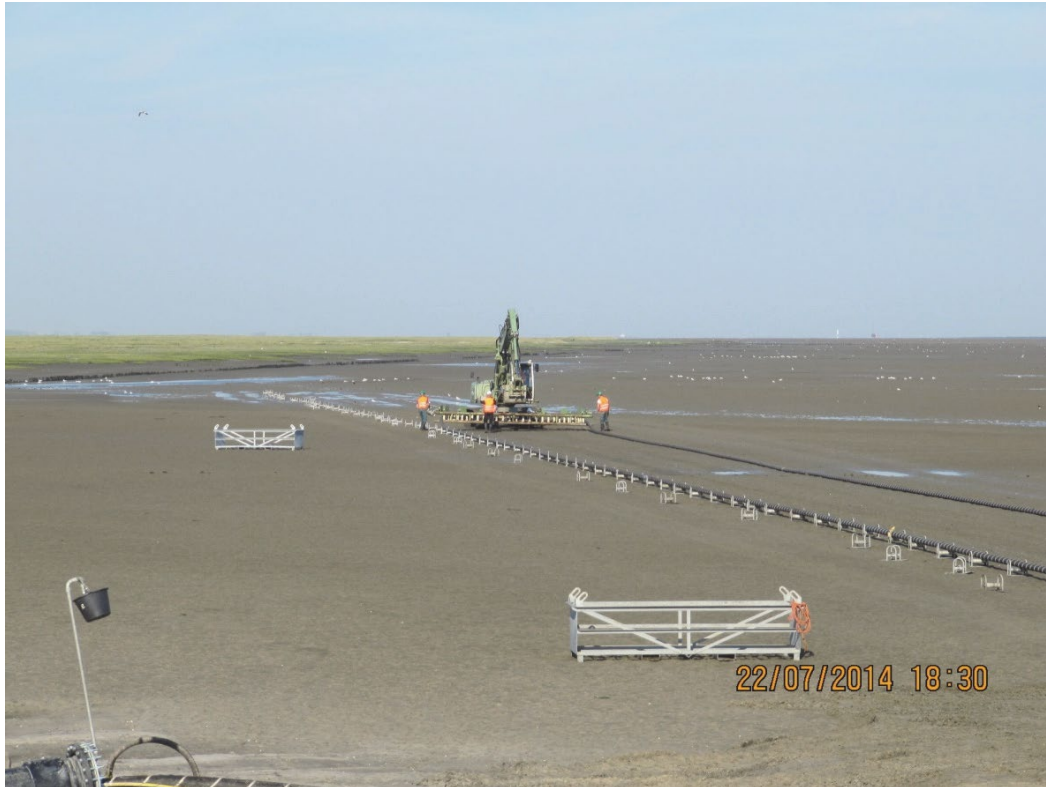
Abbildung 21: Auslegen der Kabelschleife vor dem Einzug in die Schutzrohre (Quelle: eos projekt).
