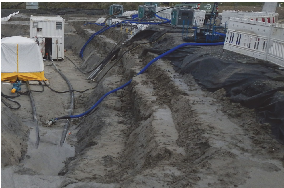
Abbildung 23: Drainage Muffengrube (Quelle: eos projekt).
