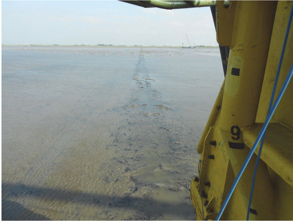
Abbildung 19: Kabelgraben nach Verlegung mit Vibro-Schwert in NW-Phase (Quelle: eos projekt).
