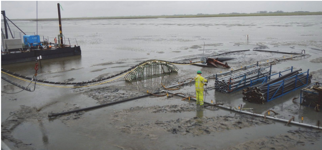
Abbildung 15: Wasserhaltung Watt (Quelle: eos projekt).
