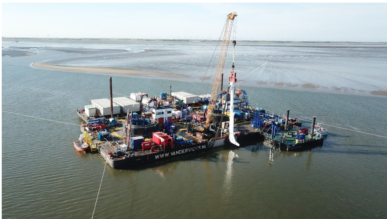
Abbildung 14: Kabelverlegebarge bei Hochwasser mit Vibrationsschwert (Quelle: TenneT).
