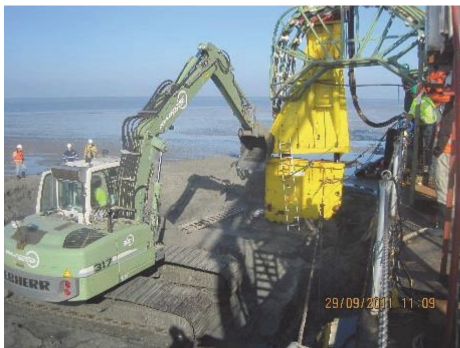
Abbildung 17: Vibrationsschwert in Startgrube (Quelle: eos projekt).
