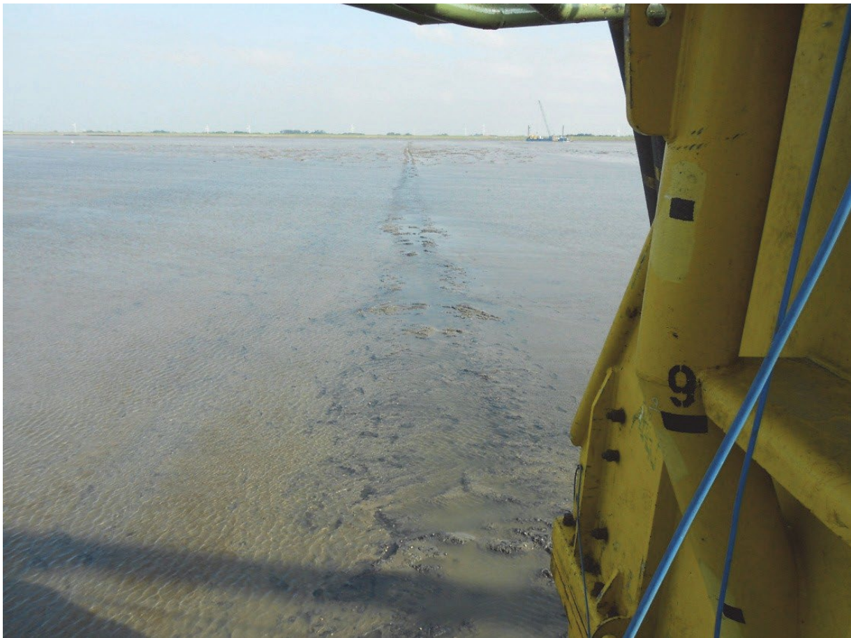
Abbildung 17: Kabelverlegung im Watt mit Hilfe eines Vibrationsschwertes (Quelle: eos projekt).
