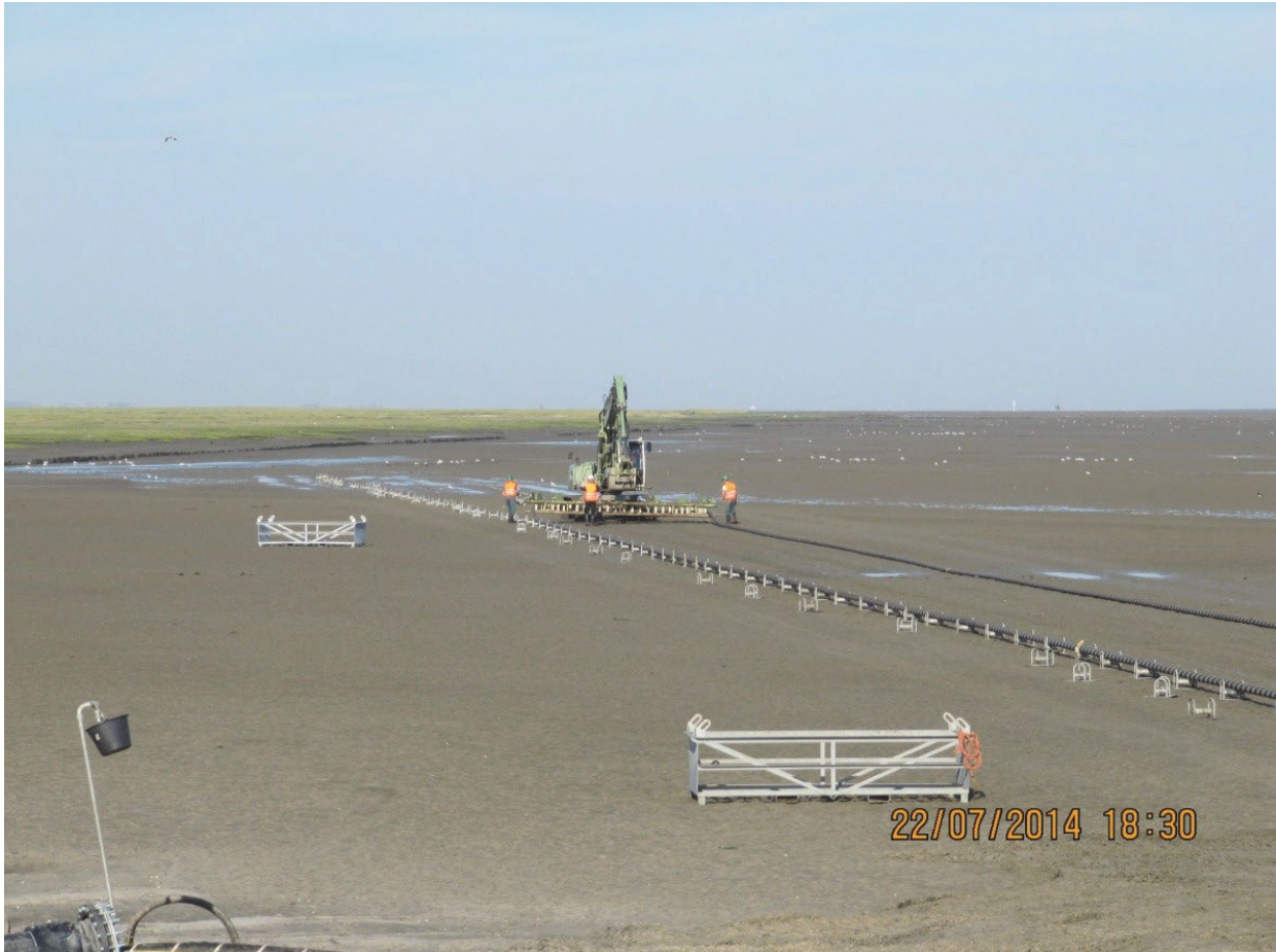
Abbildung 18: Auslegung der Kabelschleife (Quelle: eos projekt).
