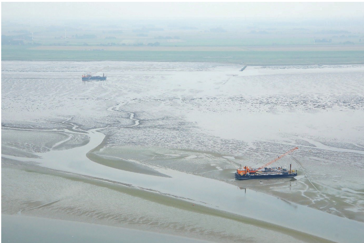
Abbildung 14: Luftbild einer exemplarischen Wasserbaustelle bei Hilgenriedersiel mit dem Arbeitsponton am Bohraustrittspunkt im Hintergrund und dem Anlege- und Fährponton am Riffgat-Fahrwasser im Vordergrund (Quelle: Tennet).
