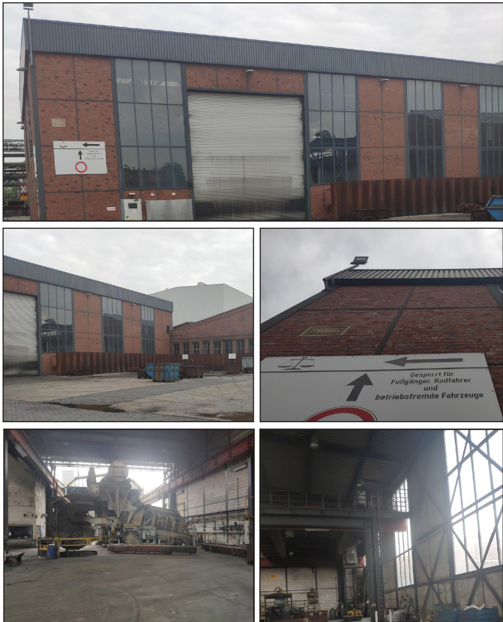
Abb.3-5: Bilder des untersuchten Gebäudebestandes (Quelle: eigene Aufnahmen)
