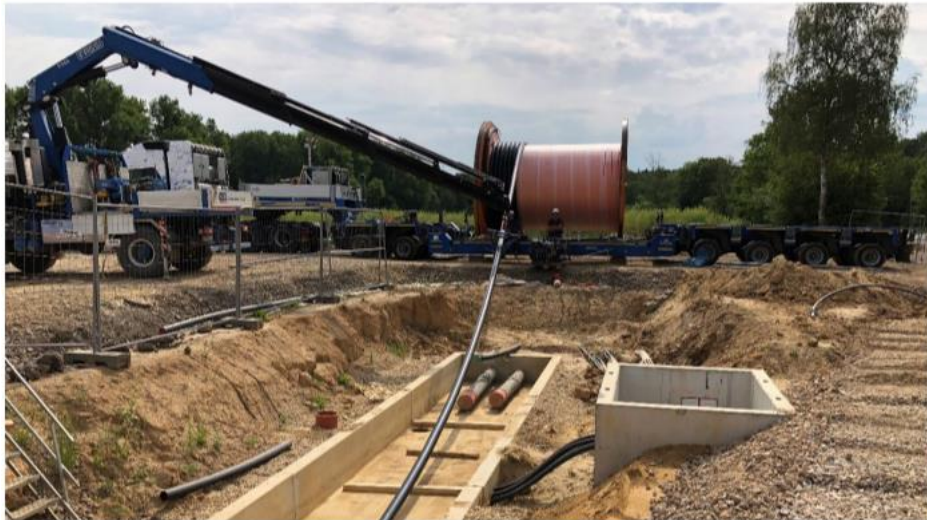
Abbildung 15: Beispiel für den Kabelzug am Spulenplatz, Quelle: Amprion GmbH
