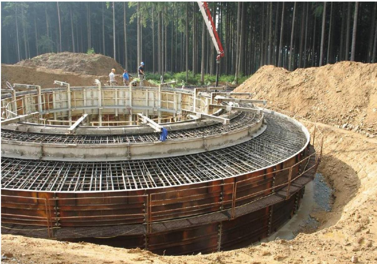
Abb. 1: Beispiel für den Bau eines Flachfundaments einer Windenergieanlage, /1/
