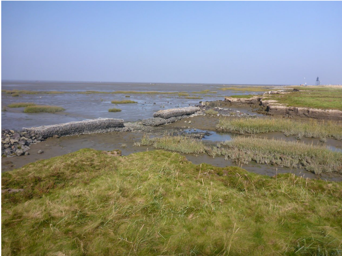
Abbildung 13: Auslassbereich der aufgeweiteten, mittleren Entwässerungsrinne (2020)
