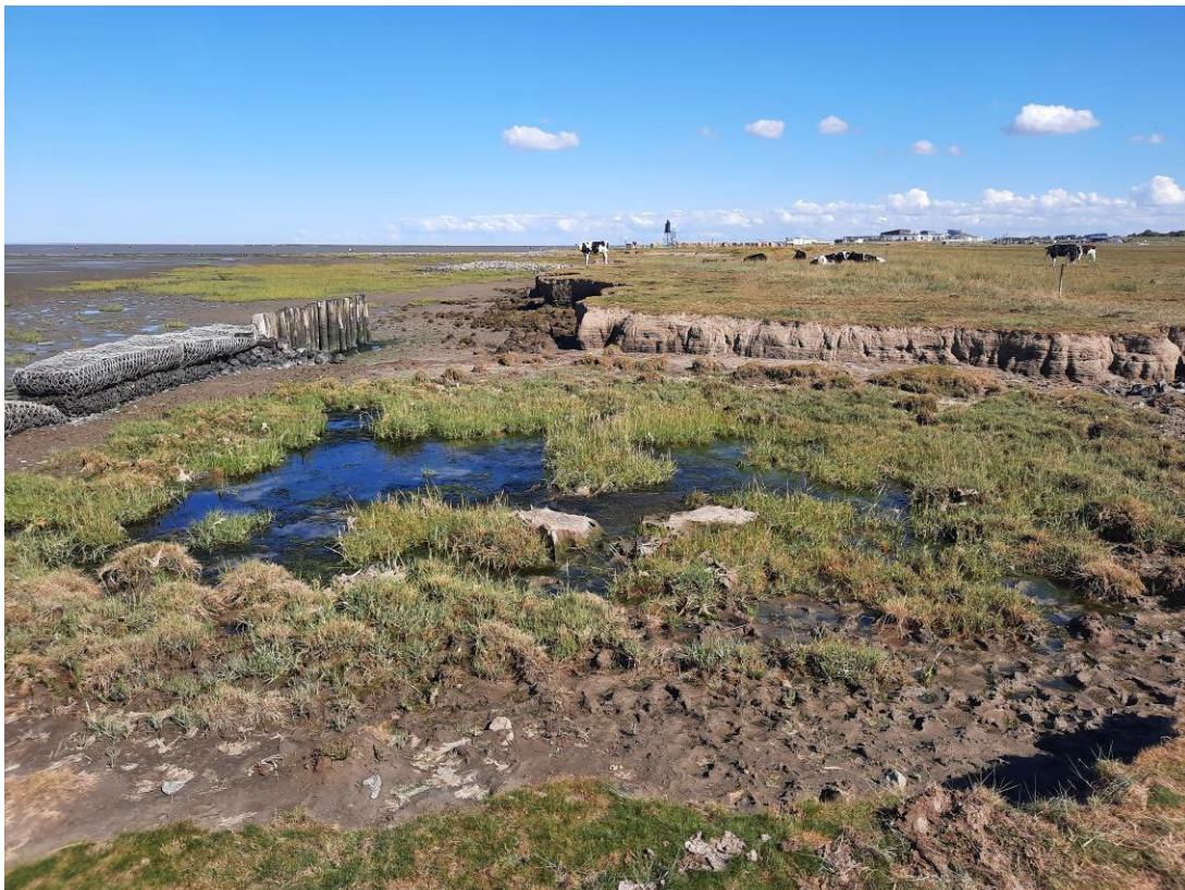
Abbildung 18: Ausgekolkter Bereich, mit vorgelagerten Sicherungselementen (2022)
