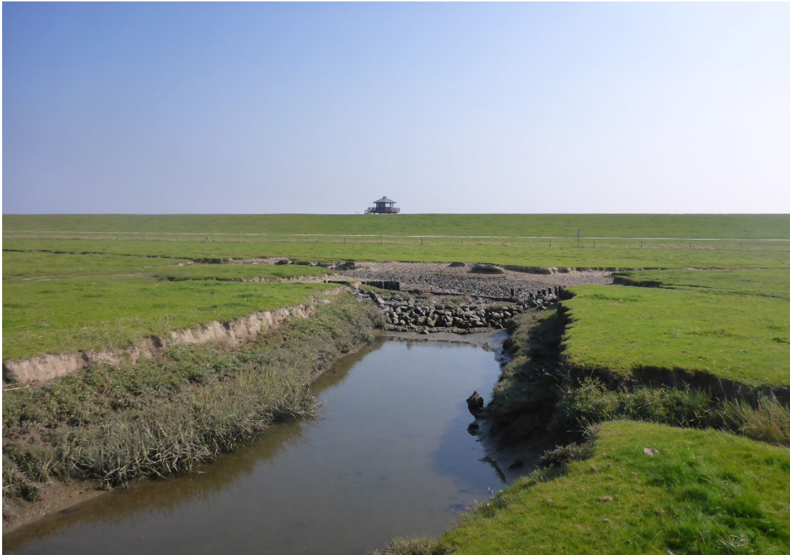
Abbildung 15: Sicherungsbauwerk im hinteren Abschnitt (2020), ca. 50 m vom Deichfuß entfernt, Rinne schwenkt Richtung Norden ab, Blick auf Deich mit Vogelbeobachtungsturm
