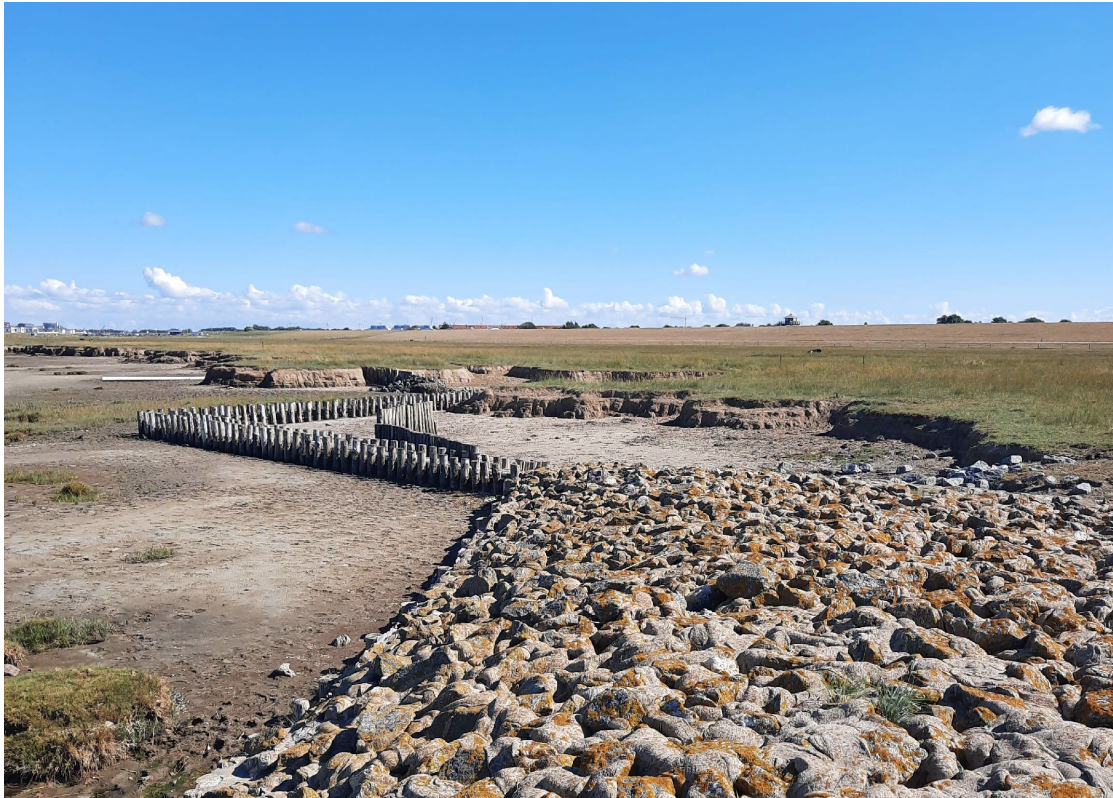
Abbildung 5: Anschlussbereich südliche Buhne an Vorlandabschnitt (2022), Sicherung mit Pfahlreihen und Gabionenkörben
