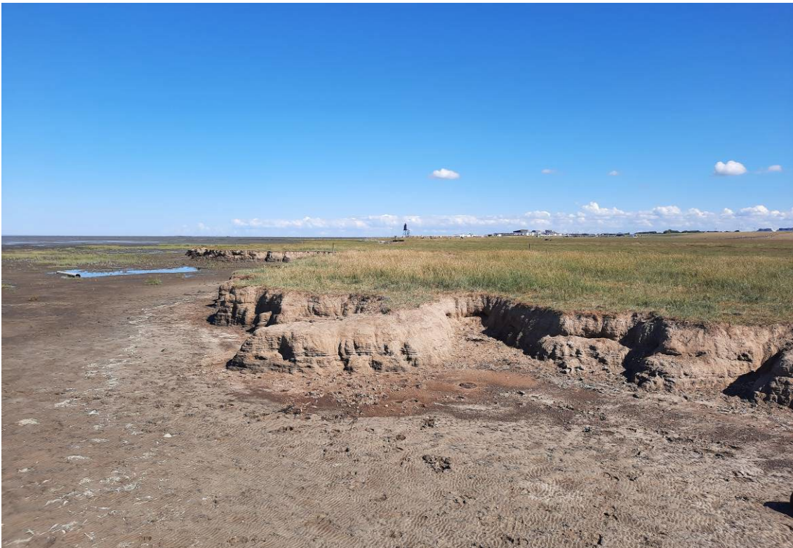
Abbildung 2: Typische Abbruchkante im ungeschützten Küstenabschnitt 2022 (1)
