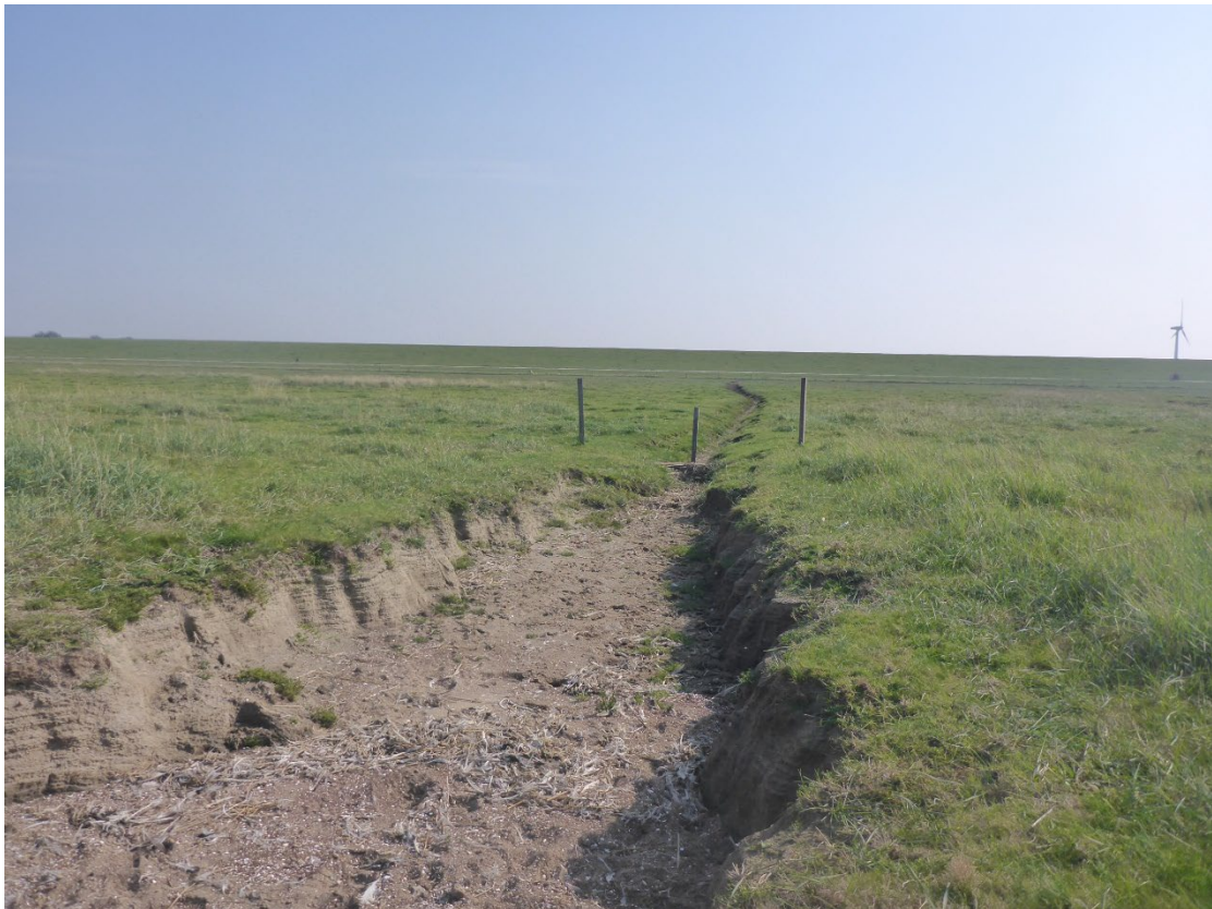
Abbildung 10: Verlandung der Entwässerungsrinne im vorderen Bereich (2020)
