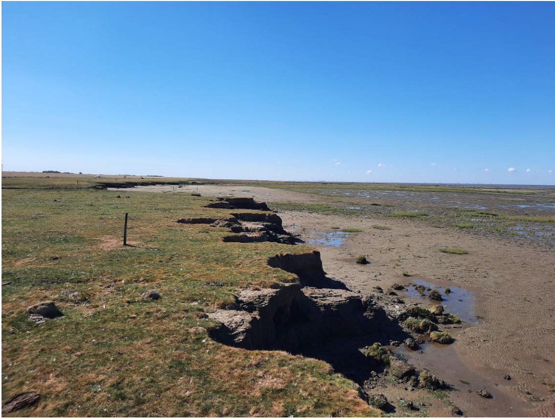
Abbildung 3: Typische Abbruchkante im ungeschützten Küstenabschnitt 2022 (2)
