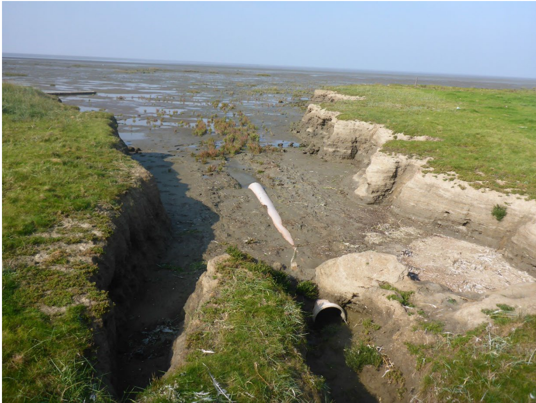
Abbildung 11: Schadhafes Entwässerungsrohr (2020)
