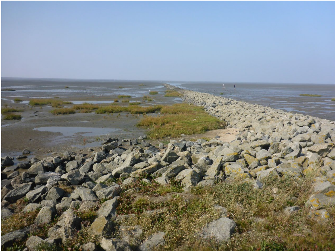
Abbildung 23: Anschluss an Buhne am nördlichen Ende des Vorlandabschnittes (2020)
