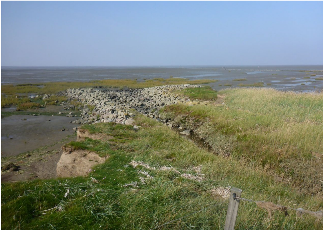
Abbildung 19: befestigter Auslaufbereich der Entwässerung aus nördlich gelegenem Vorland (2020)
