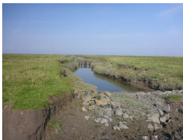
Stellenweise mit Holzpflocken und Steinschüttungen befestigter Priel in der oberen Salzwiese, am Ufer wächst die Salzmelde; Blickrichtung West (12.08.21). Foto: Heike Stieg-Lichtenberg
