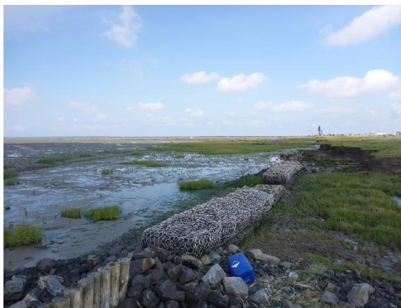
Blick auf das Queller-Watt in nördliche Richtung; im Vordergrund Befestigungen mit Steinschüttungen und Holzpflocken an der Abbruchkante der oberen Salzwiesen (11.08.21). Foto: Heike Stieg-Lichtenberg
