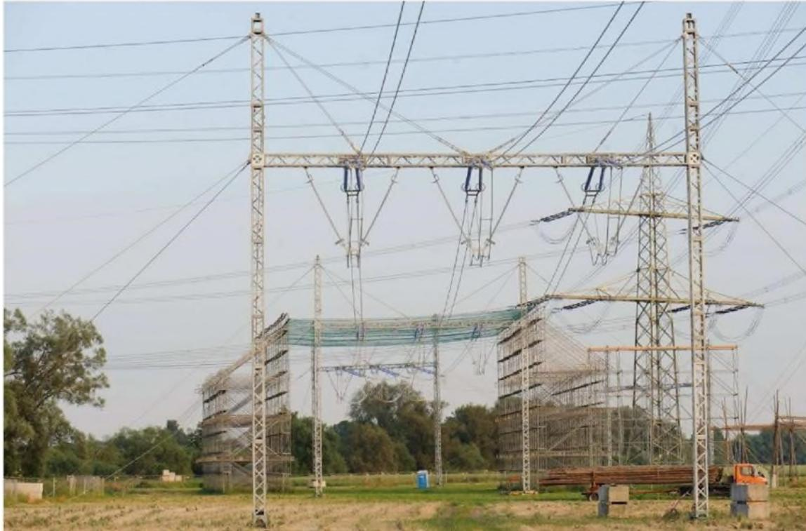
Abbildung 9: Einsatz von Provisorien (380 kV Freileitungsprovisorium für ein System, mit errichtetem Schutzgerüst im Hintergrund)
