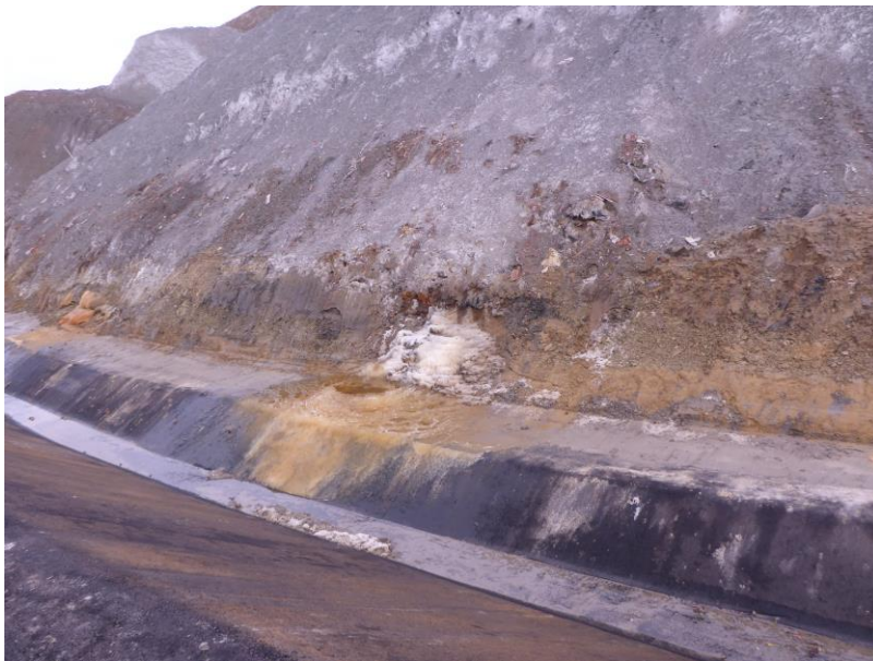
Abbildung 9: Haldenwasseraustritt am Haldenfuß, neuer Haldenrandgraben
