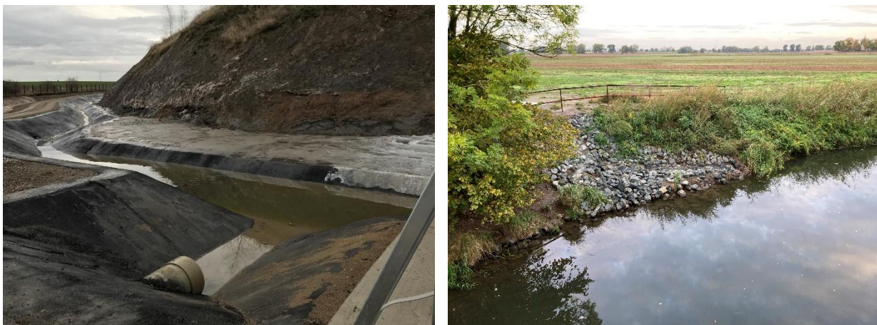
Abbildung 5-6: Sammelbecken des Haldenrandgrabens (links) und Einleitbauwerk in die Innerste (rechts)
