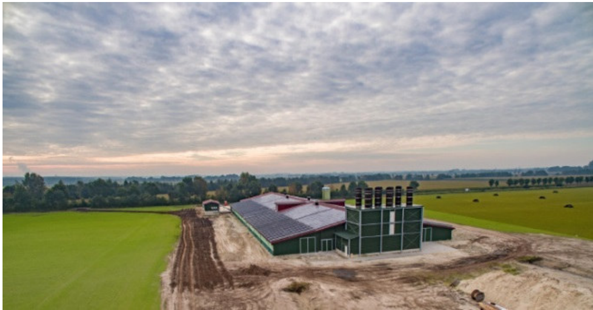
Bild 4: Beispiel für eine Stallanlage mit angeschlossener Abluftreinigungsanlage: das gereinigte Abgas wird aus Abluftkaminen, die senkrecht über der Abluftreinigungsanlage angeordnet sind, in die Atmosphäre freigesetzt (Quelle: Inno+)
