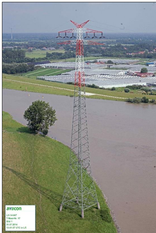
Abb. 2: Zu demontierender Mast Nr. 17 mit Einebenengestänge (Avacon 2014)
