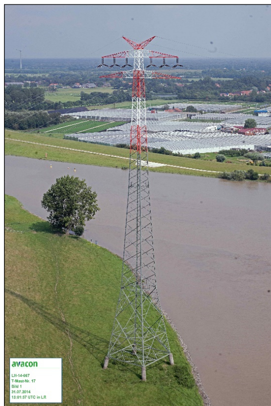
Abb. 1: Zu demontierender Mast Nr. 17 mit Eiebenengestänge (AVAICON 2014)
