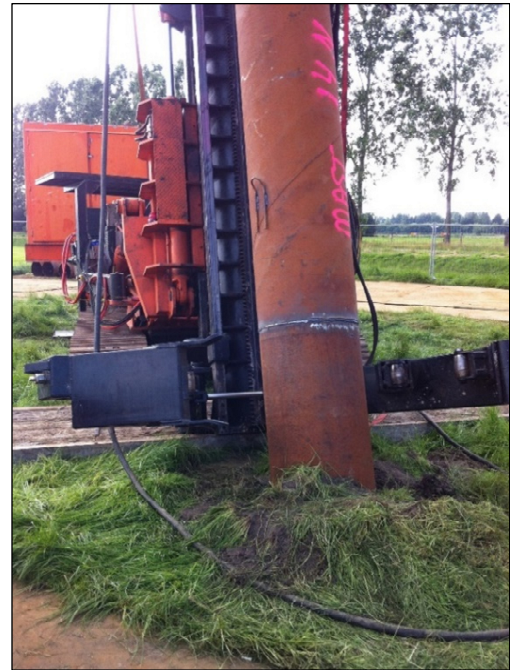
Abb. 4: Rammpfahl beim Rammen (OMEXOM 2022)
