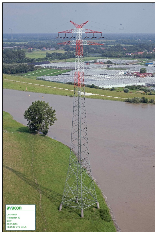
Abb. 1: Zu demontierender Mast Nr. 17 mit Einebenengestänge (AVAICON 2014)
