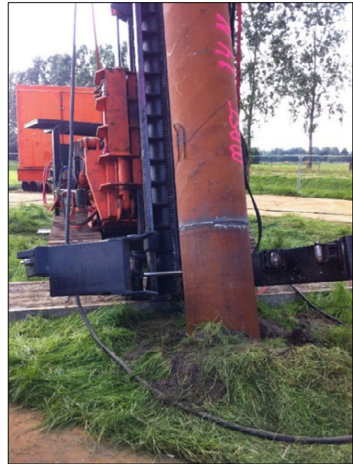
Abb. 4: Ramppfahl beim Rammen (OMEXOM 2022)
