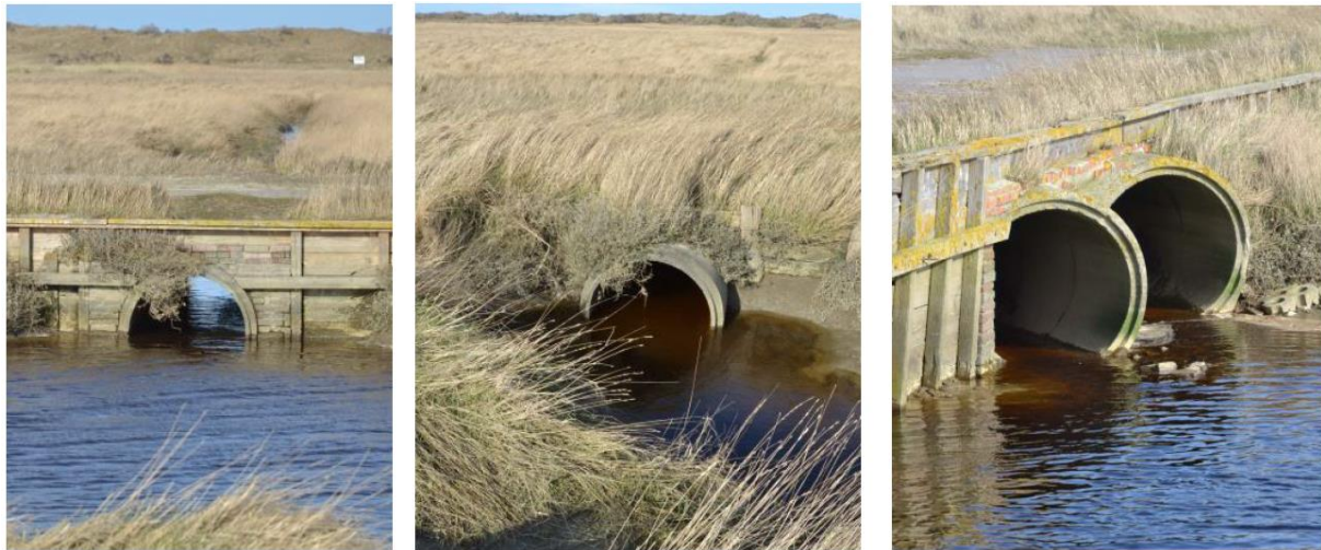
Abbildung 6-2: Rohrdurchlässe im „Katastrophenweg“
