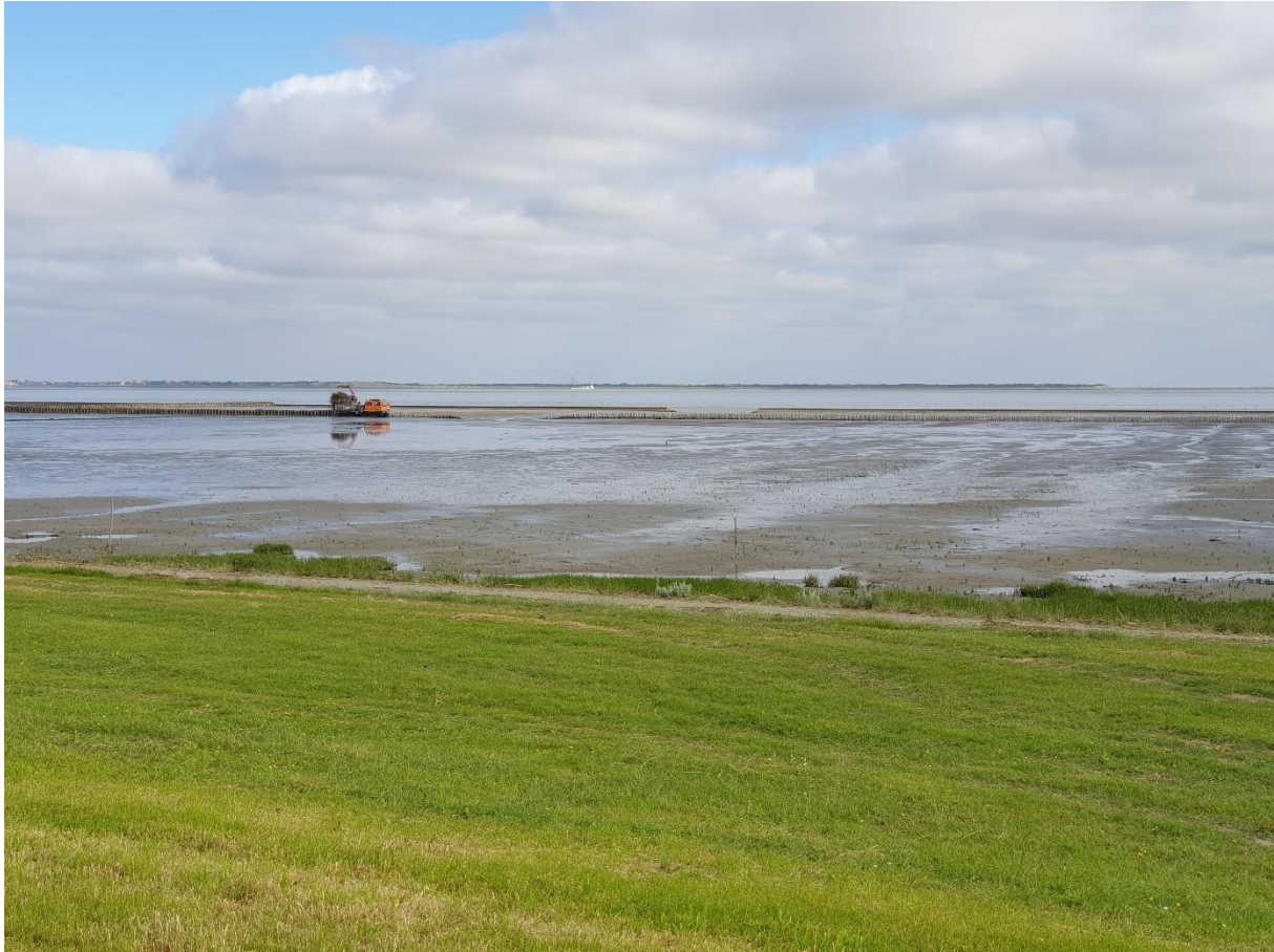
Abbildung 3-8: Bauarbeiten an den Lahnungsfeldern bei Dornum
