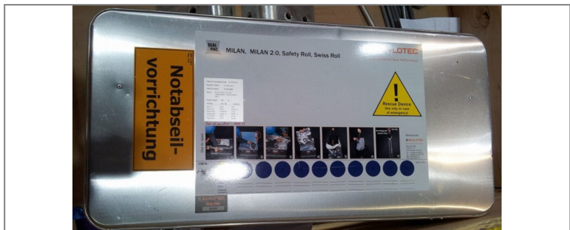
Abb. 3: Notabseilausrüstung in der WEA
