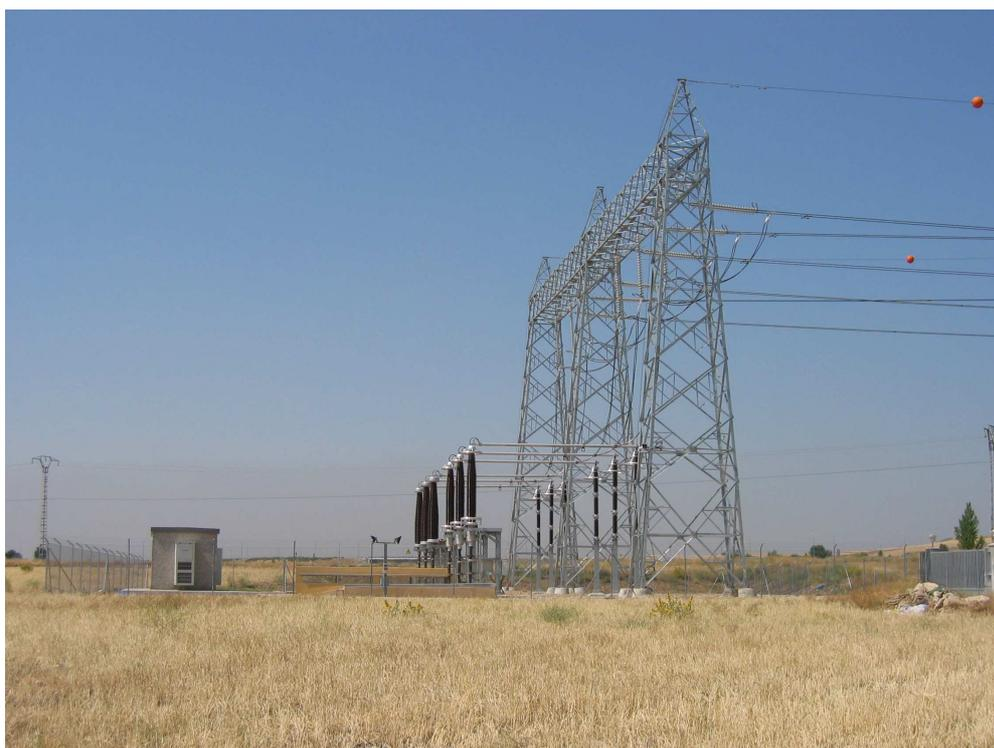
**Bild 3.9.** Kabelübergangsanlage für den Übergang von zwei Freileitungssystemen auf zwei Kabelsysteme mit Überspannungsableitern (rechts) und Kabelendverschlüssen
