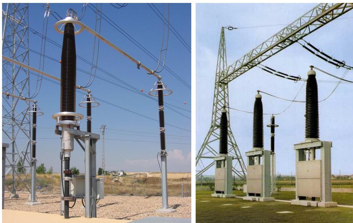
**Bild 3.5.** Kabelendverschluss (im Vordergrund) und Überspannungsableiter (im Hintergrund)
