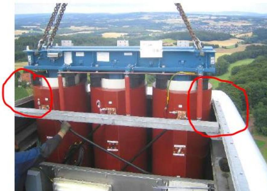
Abbildung 18-1: Führen des Transformators in das Maschinenhaus
