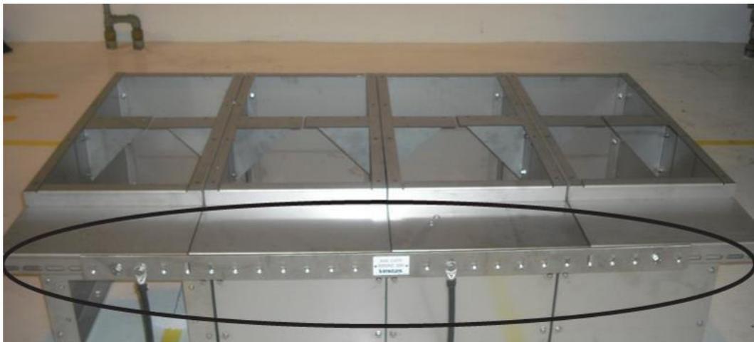
Abbildung 2-2: Auf der Rückseite eines Grundrahmens mit vier Konsolen montierte Haupterdungsschiene.
